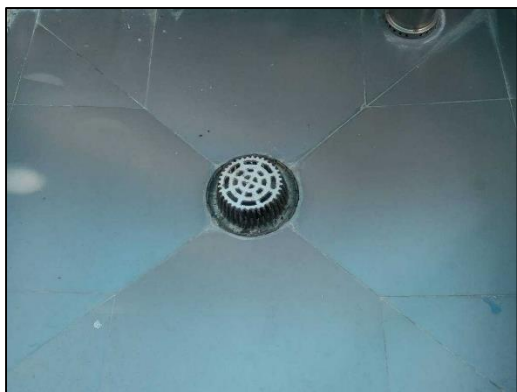
ภาพที่ 35 Roof Drain ภายในตัวอาคาร
