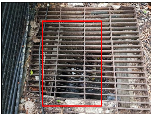
ภาพที่ 22 ตะแกรงดักขยะภายในบ่อพักน้ำ
