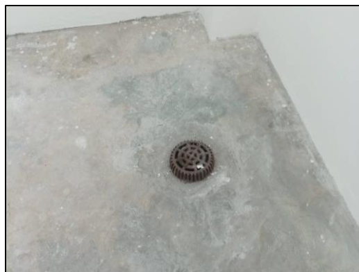
ภาพที่ 35 Roof Drain ภายในตัวอาคาร
