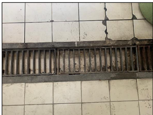
ภาพที่ 20 ร่องระบายน้ำภายในห้องพักมูลฝอย
